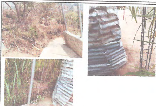
Foto 1: CERCO MURO PERIMETRAL
