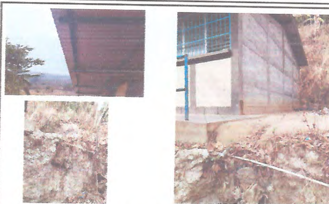
Foto 2: CANAL BAJADA DE AGUA PLUVIALES
