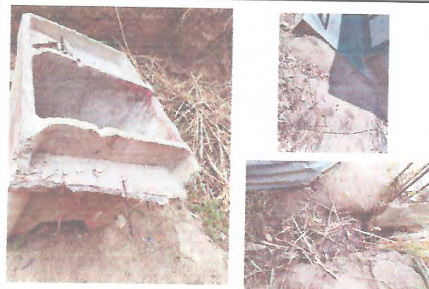
Foto 3: Reparacion de Drenaje y agua Potable
